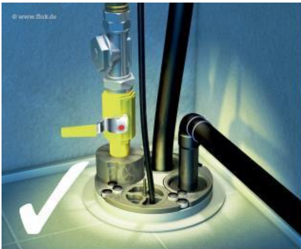
Abbildung 2: Beispiel Mehrspartenhauseinführung (theoretisch)
