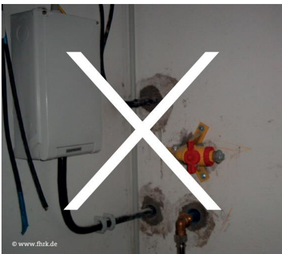
Abbildung 3: Nicht gas- und wasserdichte Ausführung
