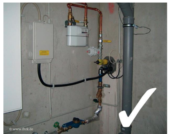
Abbildung 2: Praxisbeispiel Mehrspartenhauseinführung
