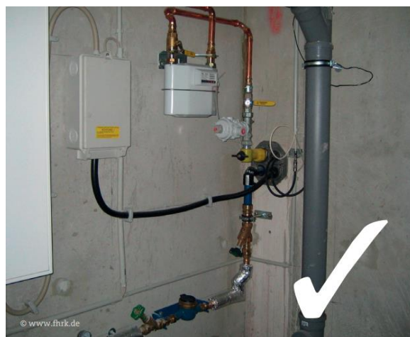
Abbildung 2: Praxisbeispiel Mehrspartenhauseinführung
