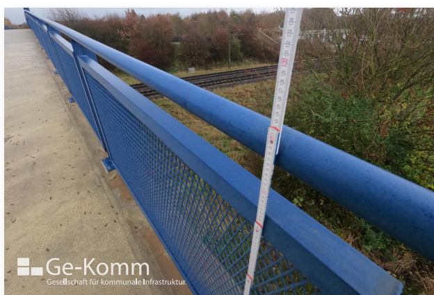
Abb. 132: Brückenbauwerk über die Bahnlinie in Richtung Alte Tecklenburger Straße (Foto: Ge-Komm GmbH)
