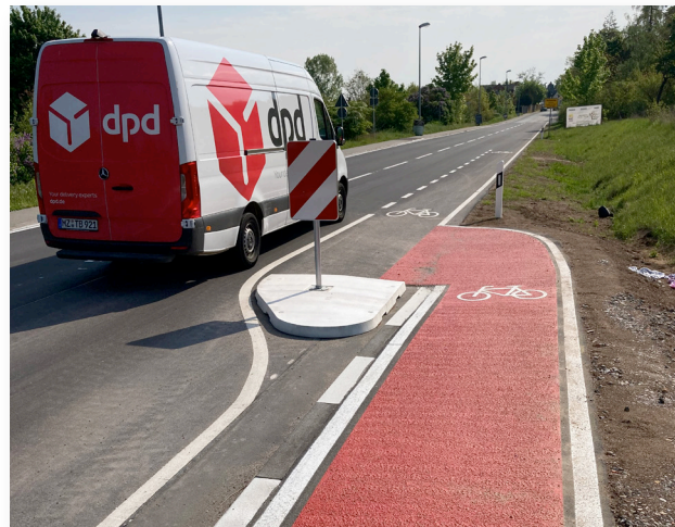
Abb. 93: Geschützter Übergang auf die Fahrbahn (Foto: Lüft GmbH)
