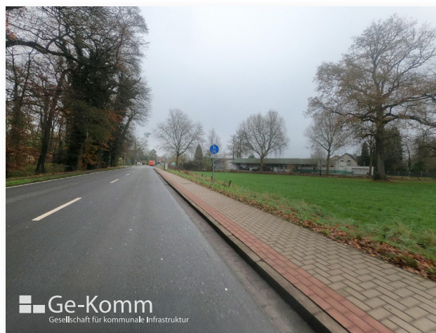
Abb. 104: Einmündungsbereich Hauptstraße / An der Feldriede (Foto: Ge-Komm GmbH)
