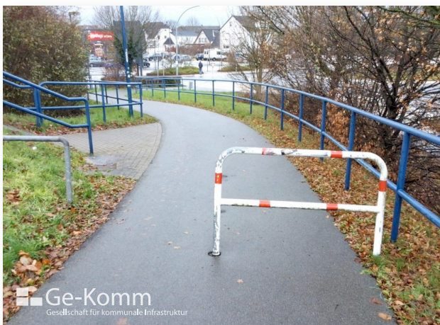
Abb. 124: Umlaufsperre im Gemeindegebiet (Foto: Ge-Komm GmbH)
