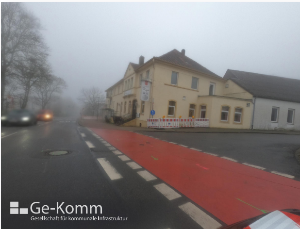
Abb. 108: Einmündungsbereich Zweirichtungsradweg Osnabrücker Straße / Roter Berg (Foto: Ge-Komm GmbH)
