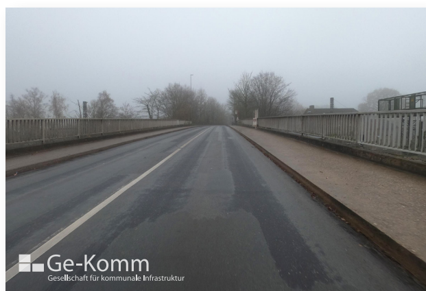
Abb. 134: Brückenbauwerk Schulstraße (Foto: Ge-Komm GmbH)
