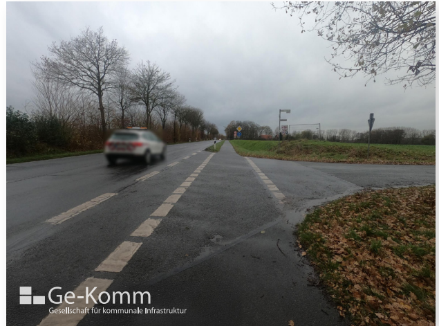
Abb. 109: Einmündungsbereich Zweirichtungsradweg Holzhauser Straße / Mühlenweg (Foto: Ge-Komm GmbH)
