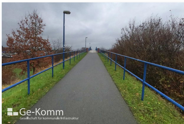
Abb. 133: Brückenbauwerk über die Bahnlinie in Richtung Alte Tecklenburger Straße (Foto: Ge-Komm GmbH)
