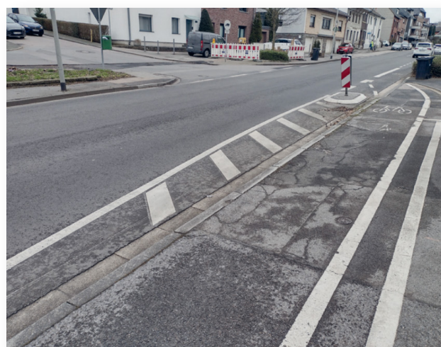
Abb. 94: Geschützter Übergang auf die Fahrbahn (Foto: Leitfaden Sofortmaßnahmen AGFS – Erstveröffentlichung innerhalb der Loseblatt- sammlung 05/2024 – Foto Straßen.NRW)
