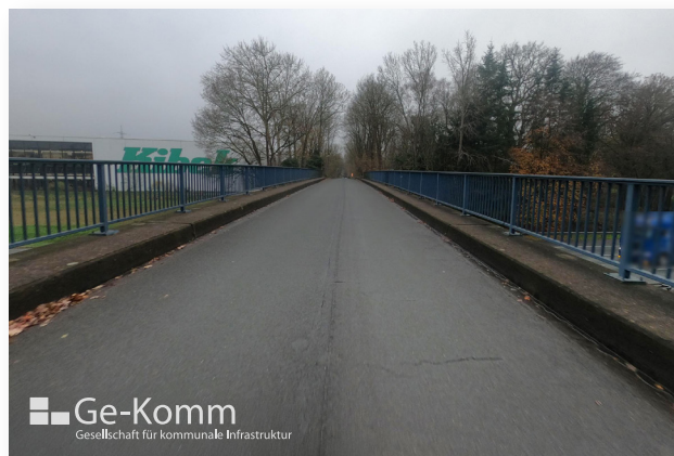
Abb. 135: Brückenbauwerk mit Radroute über die Autobahn (Foto: Ge-Komm GmbH)
